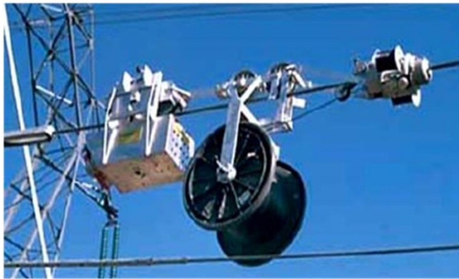
Подмотка волоконно-оптического кабеля к тросу грозозащиты
