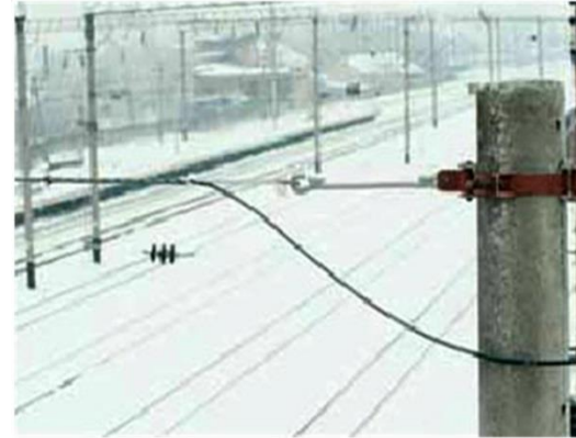
Натяжение кабеля анкерным зажимом
