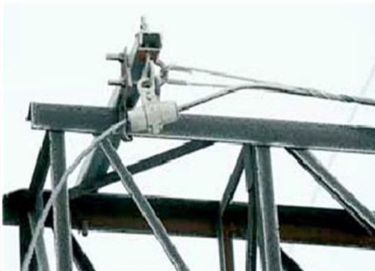
Подмотка волоконно-оптического кабеля к тросу грозозащиты
